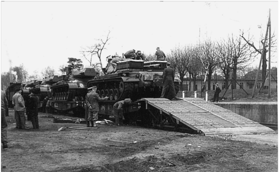
Diese Kopframpe wurde im Mai 1956 unter Aufsicht der DB aufgestellt
